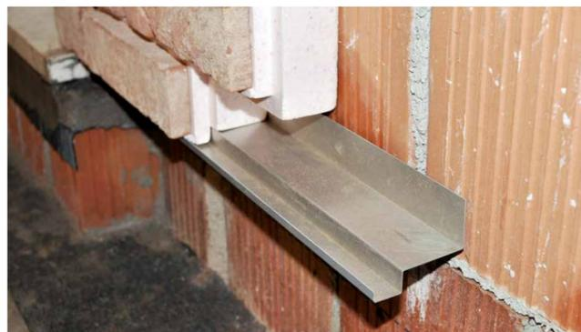
**1** Fissare in bolla il profilo di partenza lungo tutta la base della costruzione (su rivestimenti interni non è necessario).
